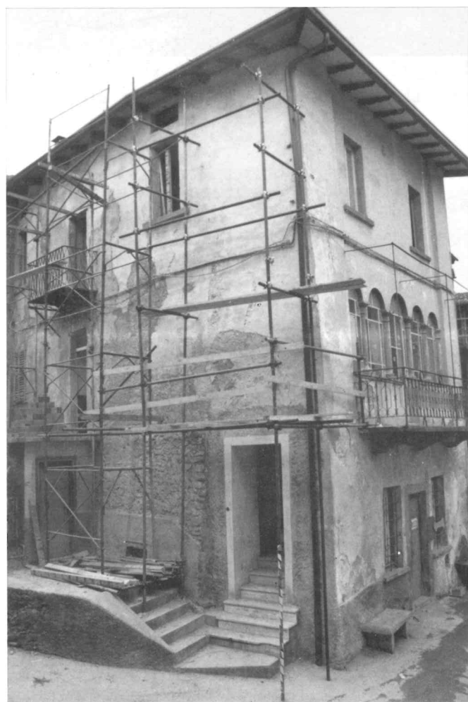
Ex casa del Curato: sistemazione della facciata Sud.
