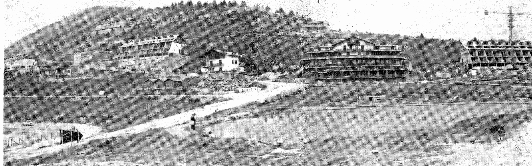
Una panoramica significativa del Colle Vareno: ormai assalito dal cemento. A destra le gru al lavoro per completare altri mastodontici edifici
